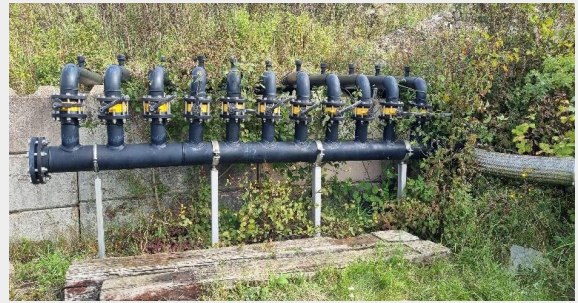
Gassammelstelle deutlich überdimensioniert
